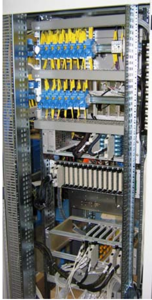
Câblage armoire, baie et coffret pour l'instrumentation
